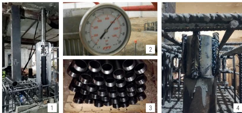
**Su característica principal es** la simplicidad comparada con las técnicas tradicionales de micropilotaje: la maquinaria a utilizar se reduce a un gato hidráulico, un pequeño bastidor en el que colocar el gato y la centralita electrohidráulica que anima al gato.
